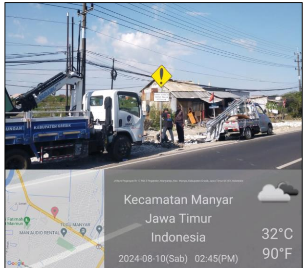
Gambar 3.2. Pemasangan Rambu Lalu Lintas
