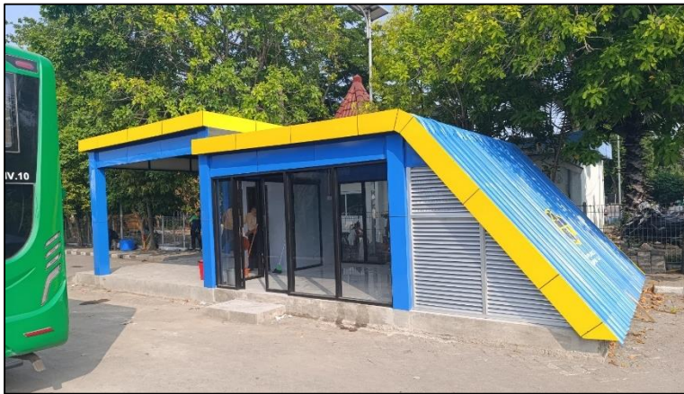
Gambar 3.2. Pembangunan Shelter Angkutan Feeder Terminal Tipe C Bunder
