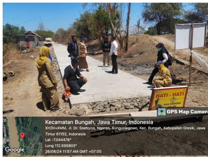
Gambar 3.17 Pembangunan Jalan Produksi Kawasan Budidaya Desa Sungonlegowo Kecamatan Bungah sumberdana APBD (DAK)
