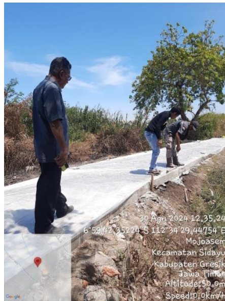
Gambar 3.18 Pembangunan Jalan Produksi Kawasan Budidaya Desa Mojoasem Kecamatan Sidayu sumberdana APBD (DAK)
