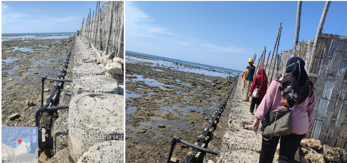
Gambar 3.21 Instalasi Pipa Air Laut pada UPT Perikanan Budidaya Air Tawar/Payau melalui sumberdana APBD (DAK)
