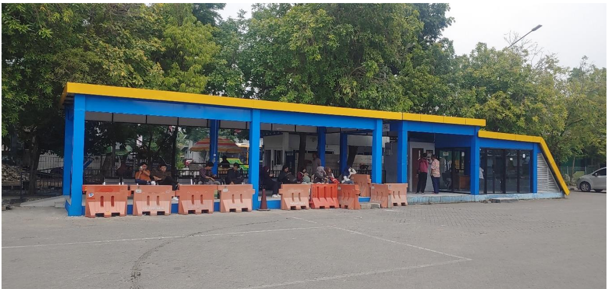
Pemeliharaan Shelter Angkutan Umum Terminal Tipe C Bunder
